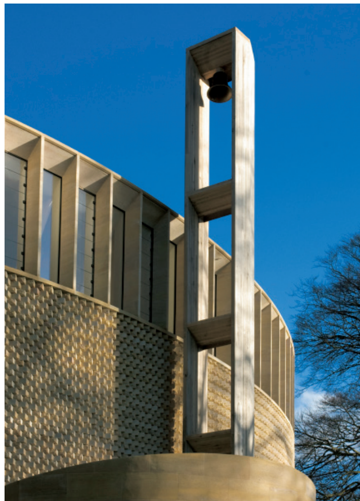
Ellipsenförmige Trommel mit drei steinernen Fassadenschichten: glatte und im Muster gesetzte Kalksteine und ein abschließender Oberlichtkranz.
